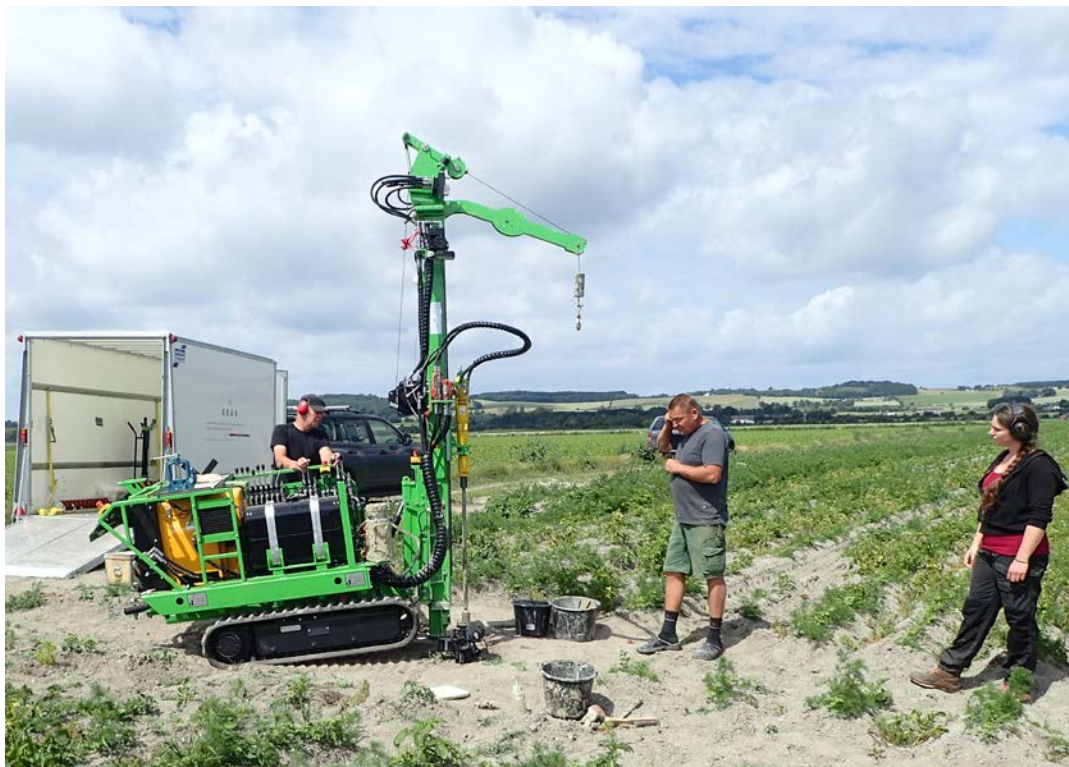
Figur 1. Borearbejdet ved boring 197.670
